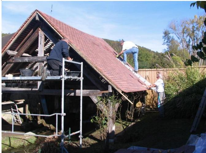
La pose des tuiles et des rives maçonnées « à l'ancienne »
