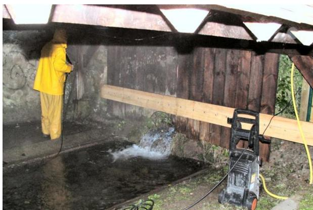
Après le remplacement de la volige abîmée, le renforcement du lattage existant et un bon nettoyage au kärcher, toute la structure en bois a reçu traitement conforme aux normes environnementales en vigueur, suivi d'une lasure de finition.
